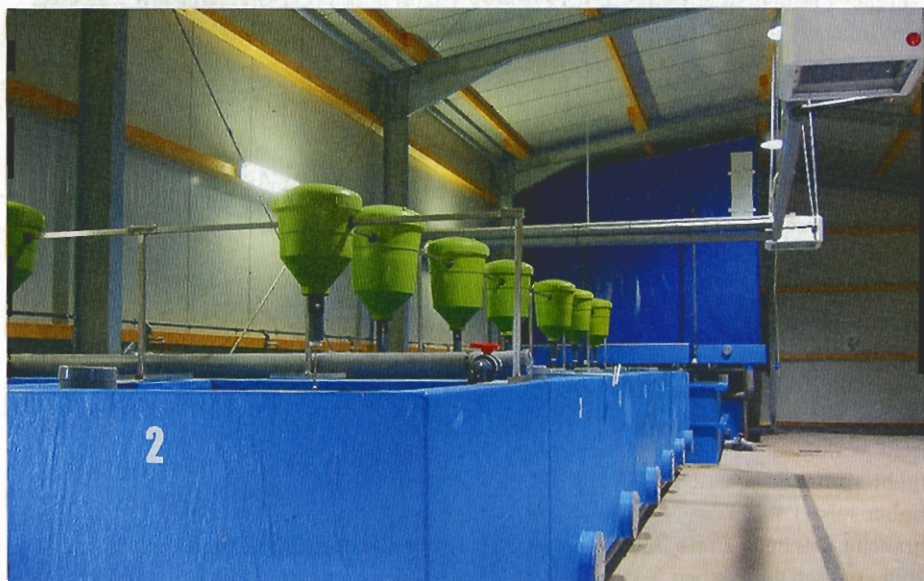
Die Fischbecken der Aquakultur-Kreislaufanlage in Pröttlin für die verschiedenen Altersgruppen. Darüber die automatische Fütterungsanlage.
